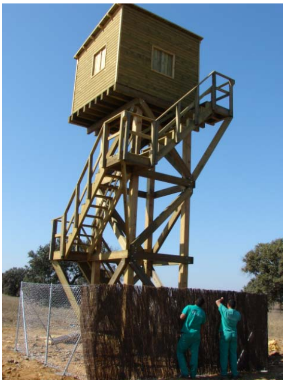
Instalación de Torreta de Vigilancia. Acción C.4
