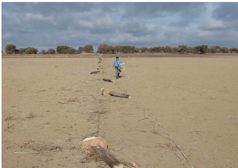
Retirada de vallado en Laguna Grande y mediciones
