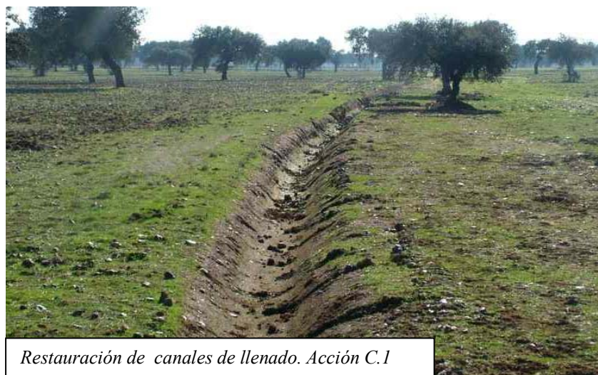
Restauración de canales de llenado. Acción C.1
